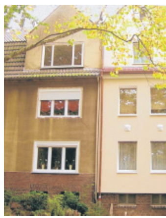
Alt gegen Neu: Wer gut saniert, spart bares Geld.
